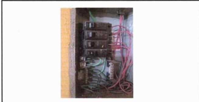
Foto 1: CAMBIO DE FLIP-ON DE 20 Y 15 AMPERIOS A 40 AMPERIOS POR SOBRECARGA DE CORRIENTE
